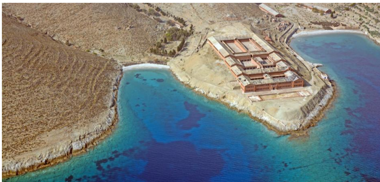
Εικόνα 31: Άποψη των κτηρίων των φυλακών της Γυάρου (© Π. Δενδρινός/MOM)
