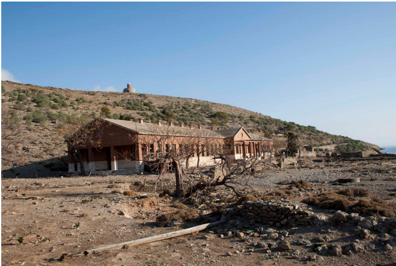
Εικόνα 34: Άποψη των βοηθητικών κτηρίων των φυλακών της Γυάρου (© Π. Δενδρινός/MOm)
