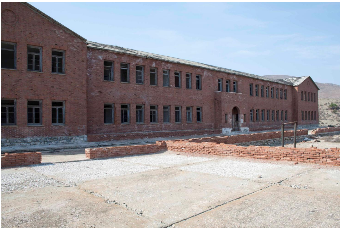
Εικόνα 32: Άποψη των κτηρίων των φυλακών της Γυάρου (© Π. Δενδρινός/MOm)
